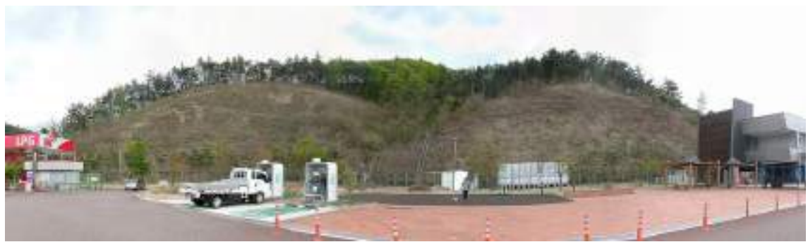
영천절토 41 (관리이정 0.349~0.540km / 7공구 STA.0+349~0+540)
