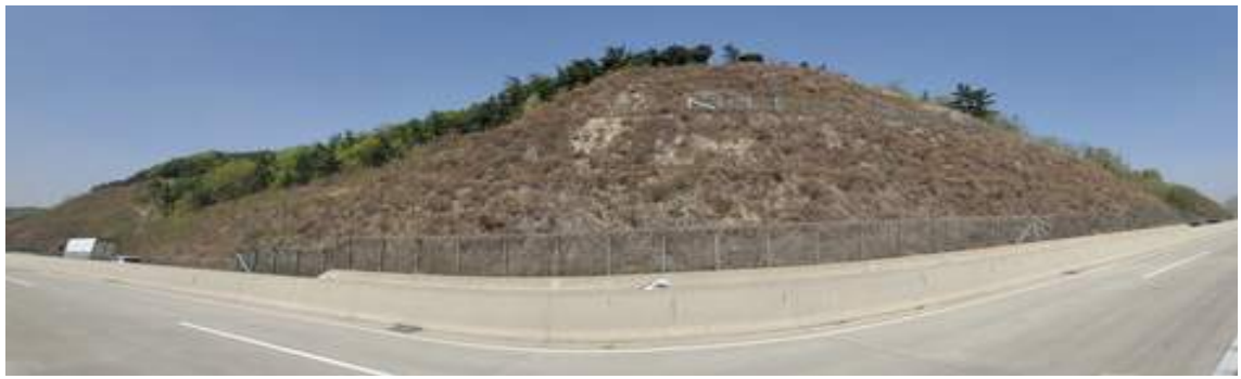
상주절토 15 (관리이정 18.104~18.334km / 3공구 STA.2+090~2+320)
