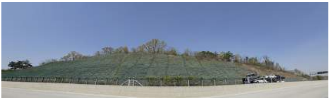
영천절토 51 (관리이정 72.378~72.588km / 8공구 STA.7+020~7+200)
