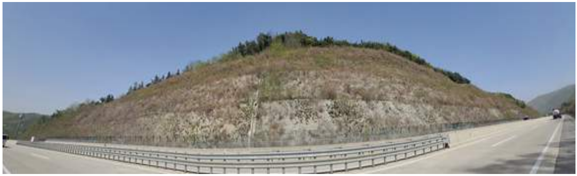
상주절토 14 (관리이정 17.304~17.504km / 3공구 STA.1+290~1+490)
