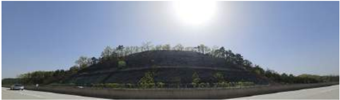
영천절토 54 (관리이정 74.338~74.518km / 8공구 STA.8+980~9+160)
