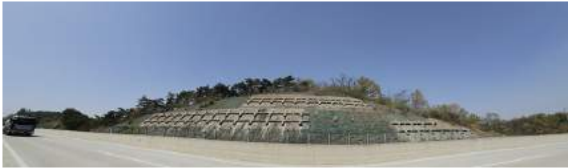
상주절토 50 (관리이정 71.71.478~71.718km / 8공구 STA.6+120~6+360)
