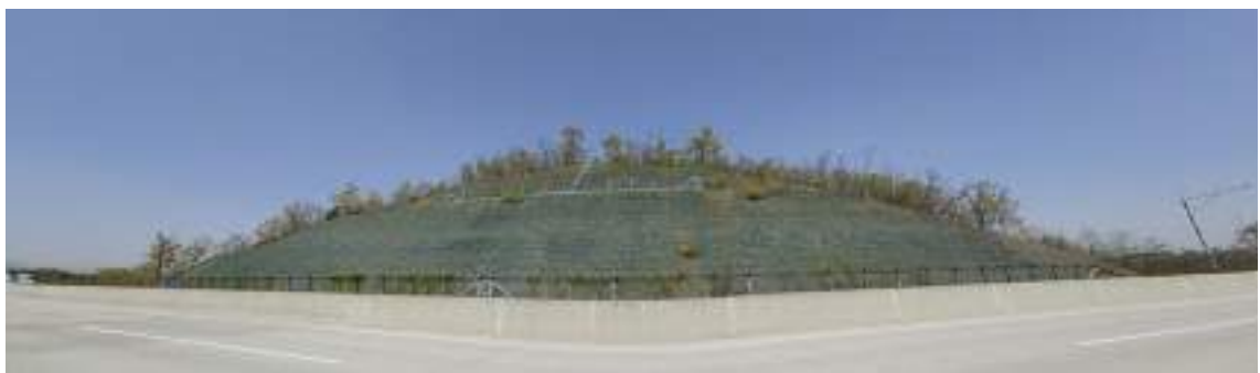
상주절토 56 (관리이정 74.962~75.098km / 8공구 STA.9+604~9+740)
