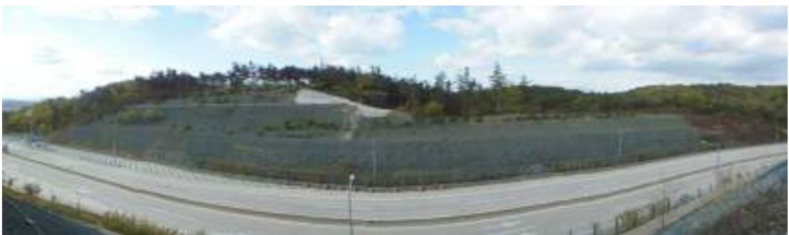
영천절토 59 (관리이정 1.600~1.723km / 8공구 화산JCT RA좌측 STA.1+600~1+723)
