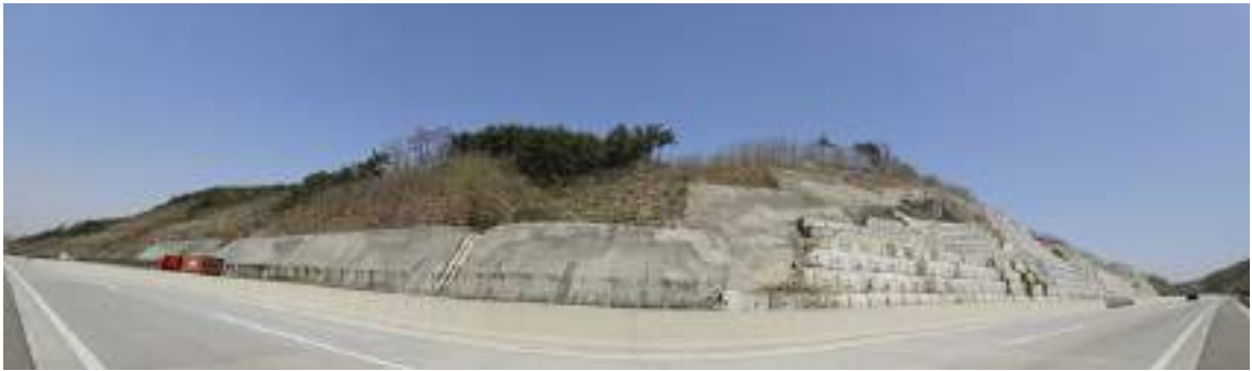
영천절토 38 (관리이정 54.478~54.928km / 6공구 STA.10+260~10+710)
