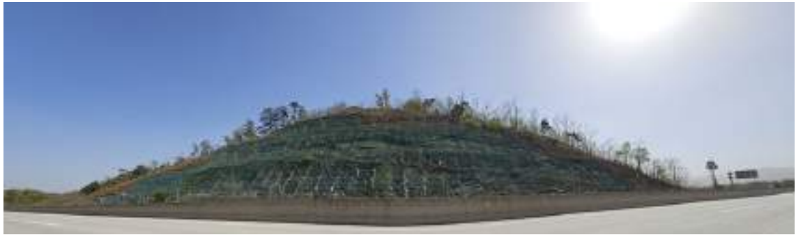
영천절토 46 (관리이정 70.058~70.418km / 8공구 STA.4+700~5+060)
