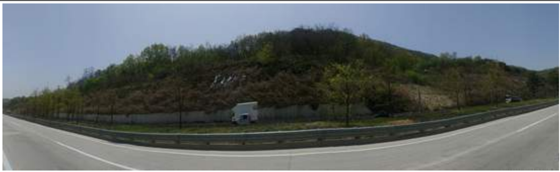
영천절토 18 (관리이정 22.924~23.494km / 3공구 STA.6+910~7+480)
