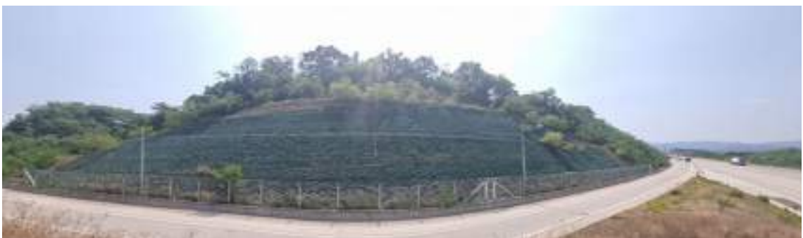
영천절토 60 (관리이정 0.140~0.260km / 8공구 화산JCT RD우측 STA.0+140~0+260)
