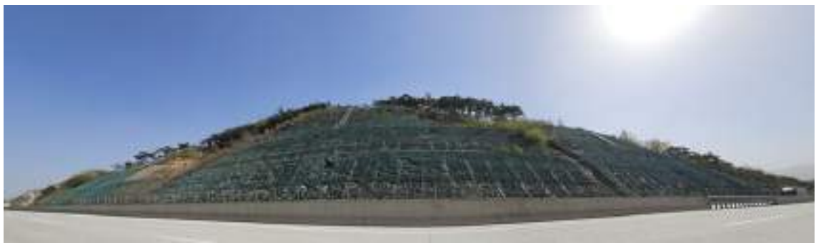
상주절토 47 (관리이정 70.498~70.778km / 8공구 STA.5+140~5+420)
