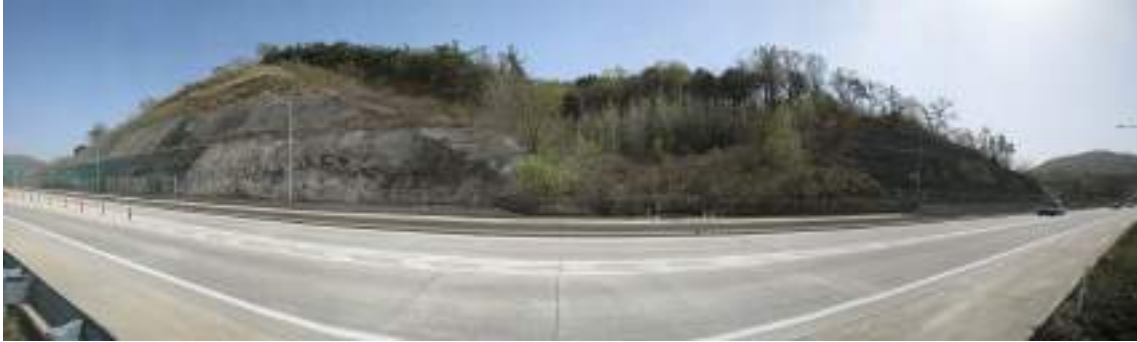
영천절토 33 (관리이정 0.360~0.690km / 5공구 군위R-A(본선)STA.0+360~0+690
