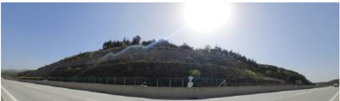
영천절토 40 (관리이정 56.078~56.398km / 7공구 STA.0+520~0+840)
