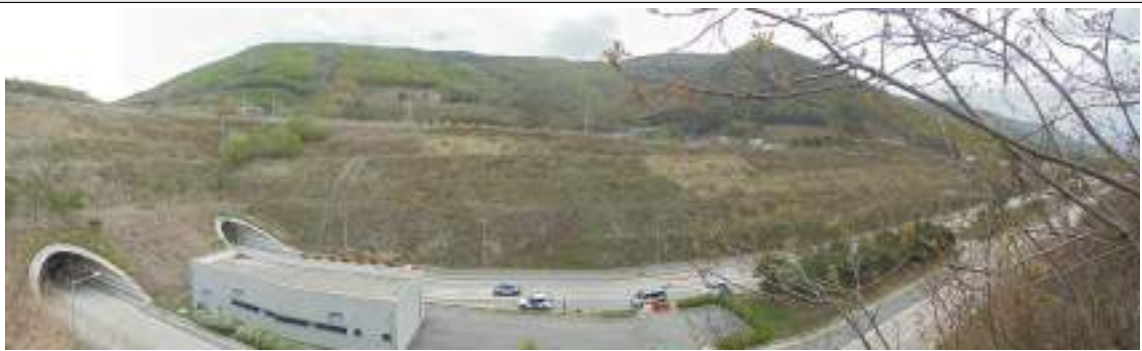
영천절토 17 (관리이정 21.614~22.054km / 3공구 STA.5+600~6+040)
