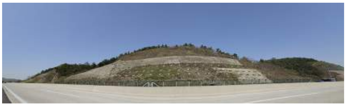
상주절토 42 (관리이정 58.638~58.798km / 7공구 STA.3+080~3+240)
