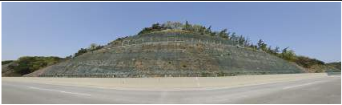
영천절토 31 (관리이정 40.025~40.175km / 5공구 STA.3+790~8+940)
