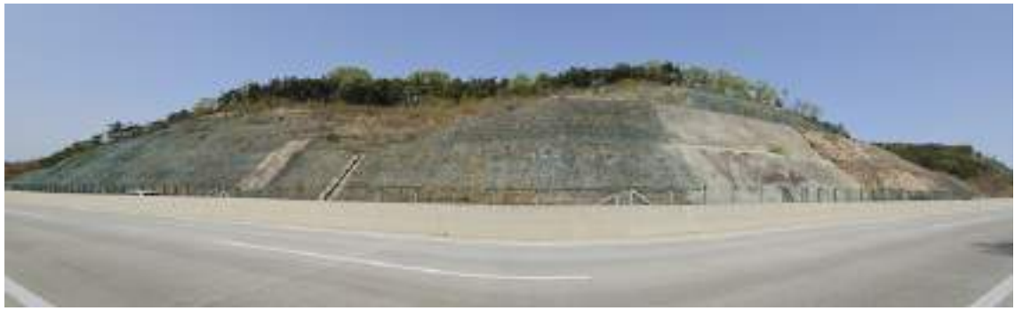
상주절토 30 (관리이정 38.525~38.685km / 5공구 STA.2+290~2+450)
